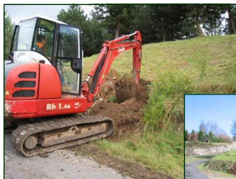
Installation de piézomètres
