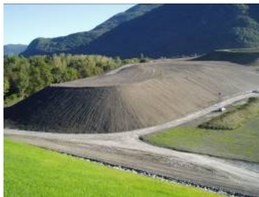
Décharge des Boues en cours de réhabilitation
