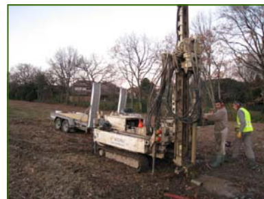
Pose de piézomètres
