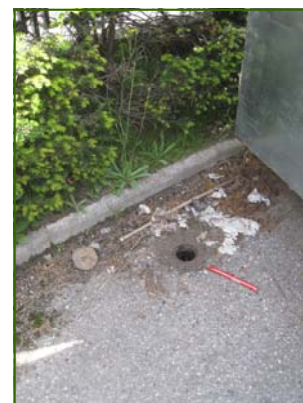
Pose de piézomètres
